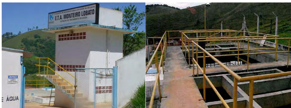
**Figura 60: ETA Sede de Monteiro Lobato, vistas da entrada e das unidades de floculação e decantação.**
