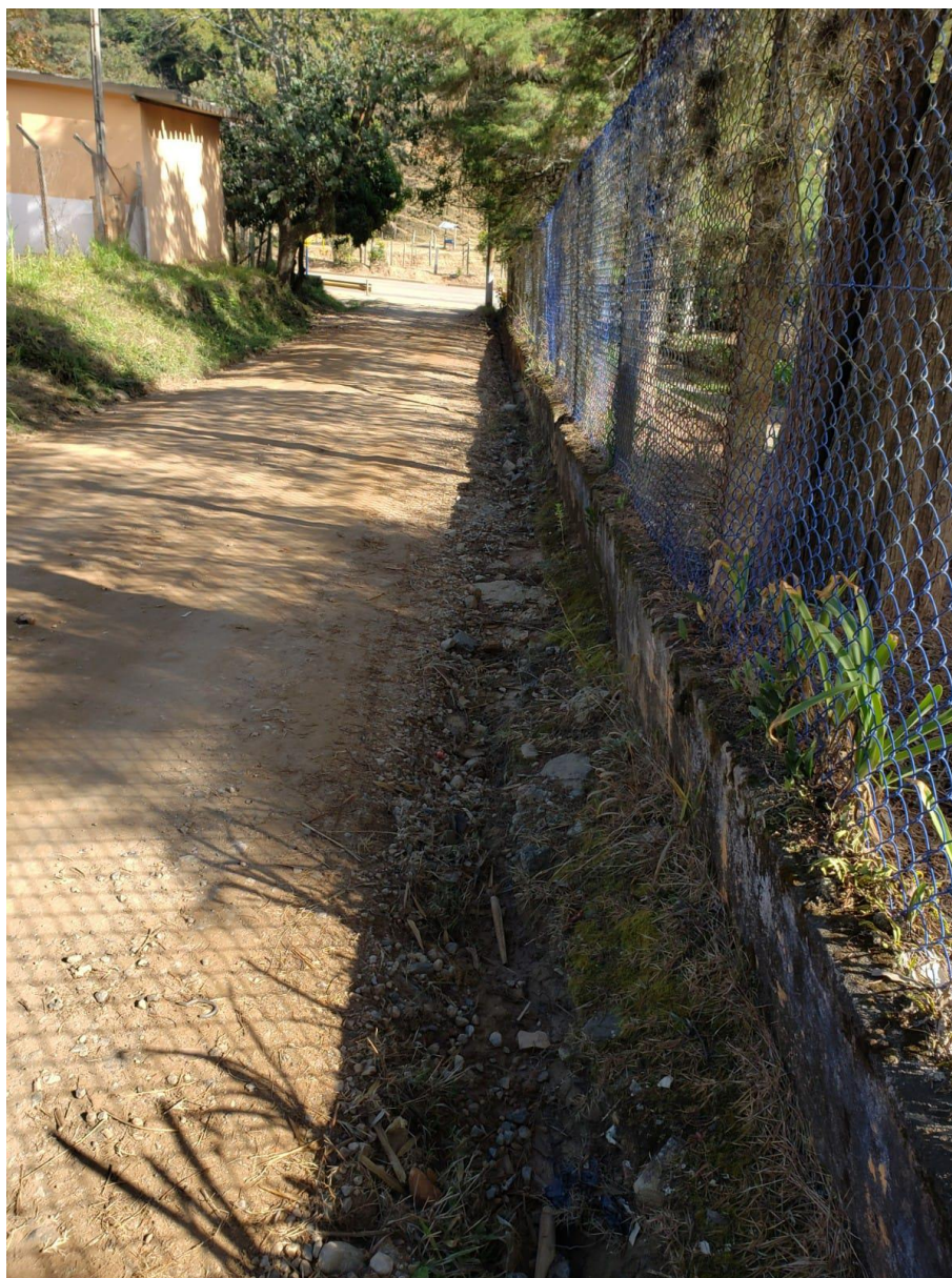
Figura 3 – Descida de água, formando canaleta natural.
