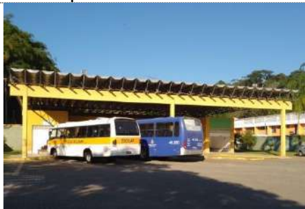
Quadro 5: Transporte Rodoviário
