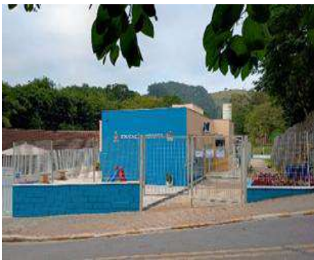
Imagem 5 Fachada da Pré-Escola (ampliação)2025
