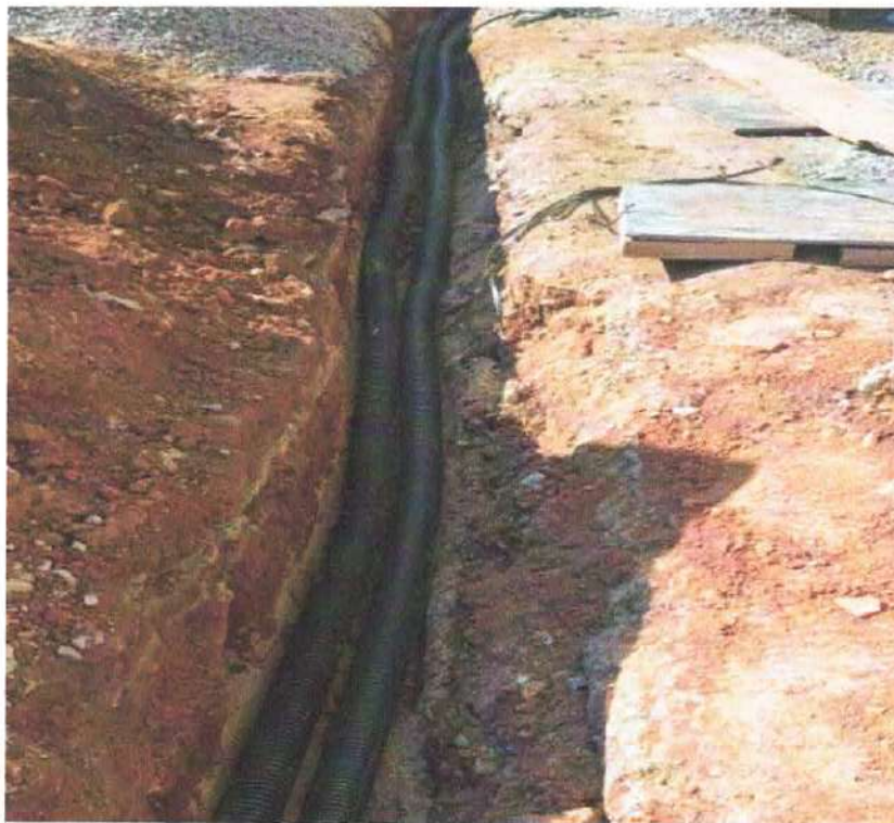
Foto 10: Instalação de infraestruturas elétricas.
