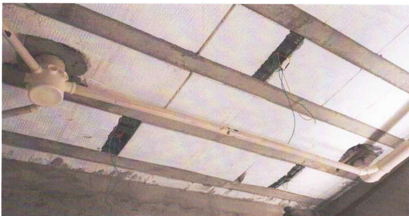
Foto 9: Instalação hidráulicas e elétricas.
