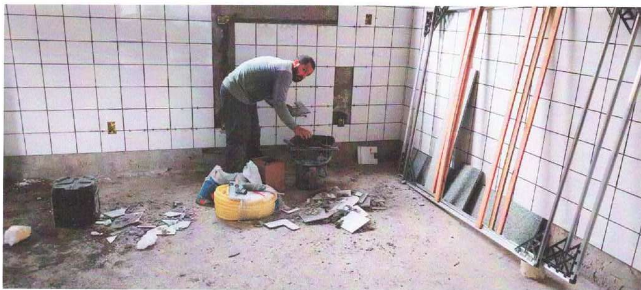
Foto 5: Assentamento de revestimento cerâmico
