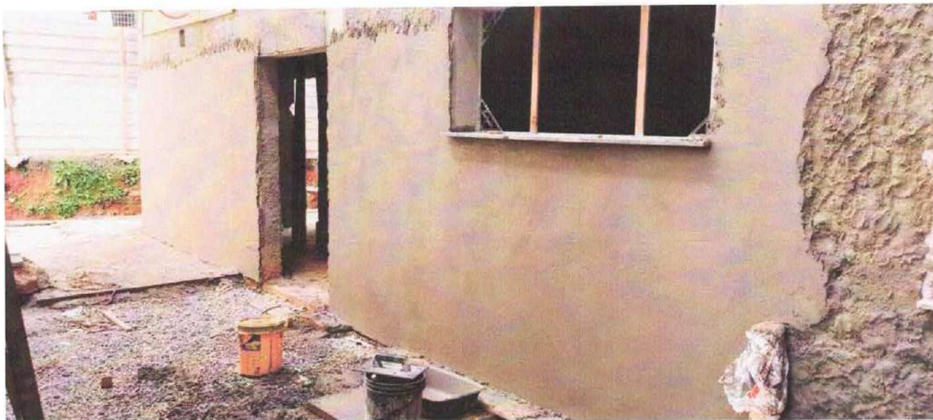
Foto 2: Reboco das paredes externas
