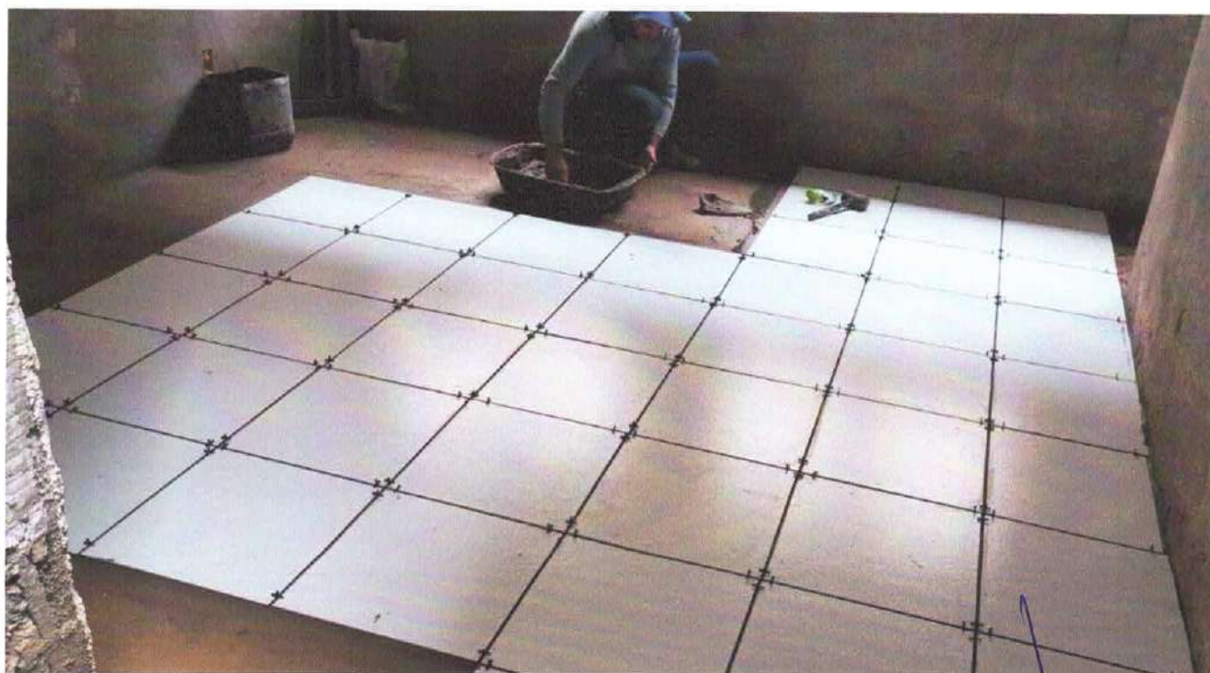
Foto 13: Instalação de piso cerâmico.
