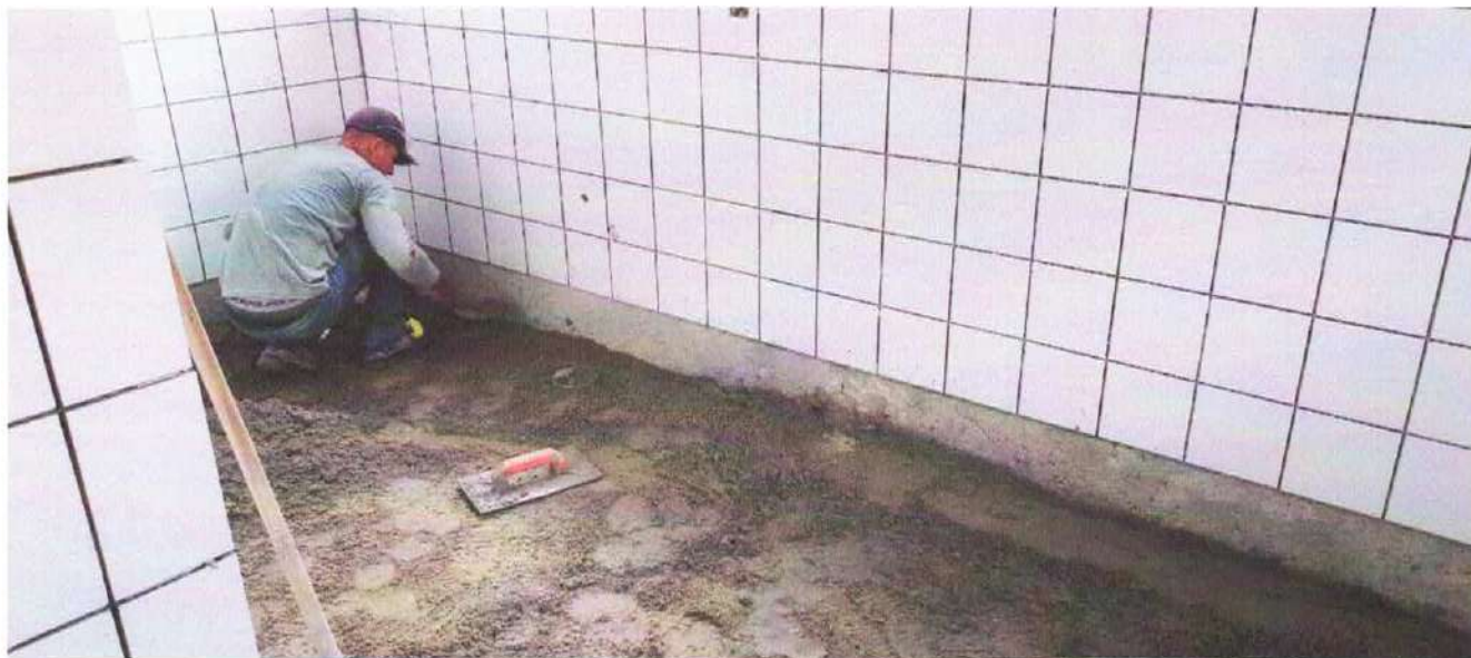
Foto 4: Contrapiso para a instalação dos pisos porcelanato
