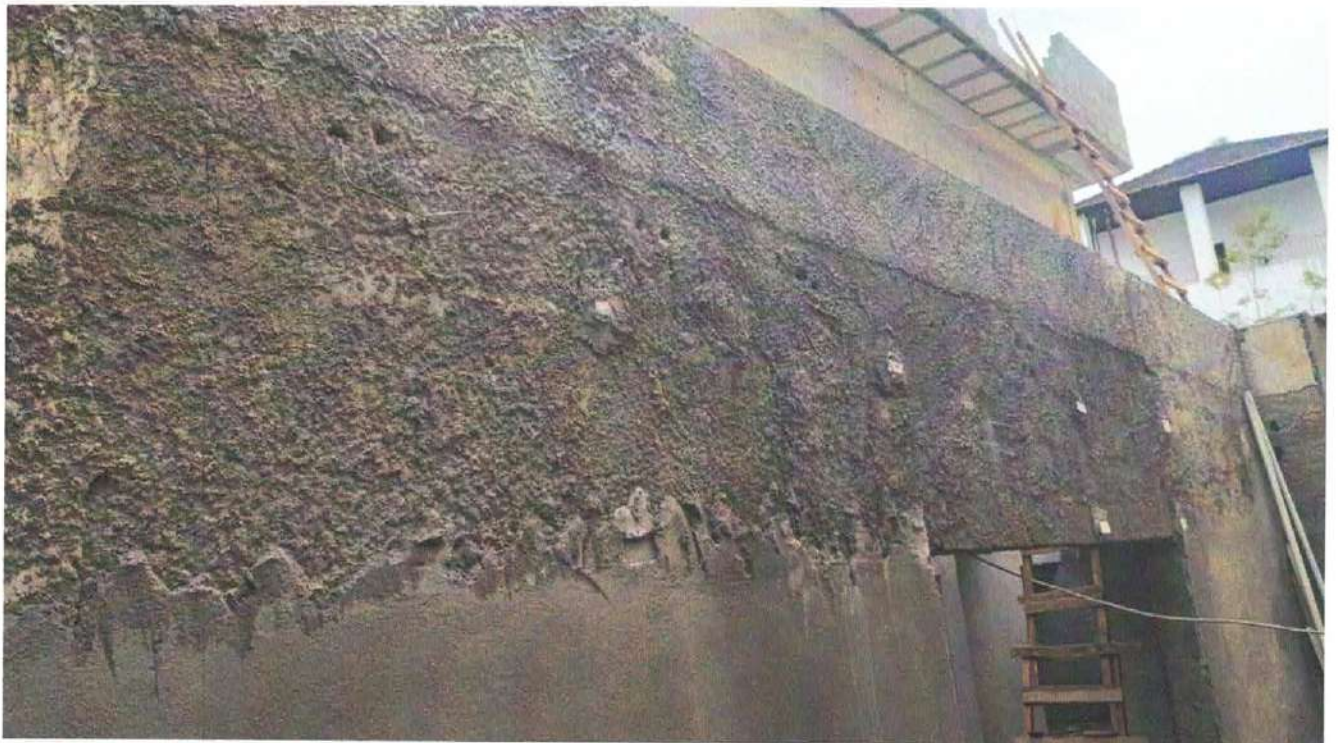
Foto 1: Chapisco e taliscas das paredes externas
