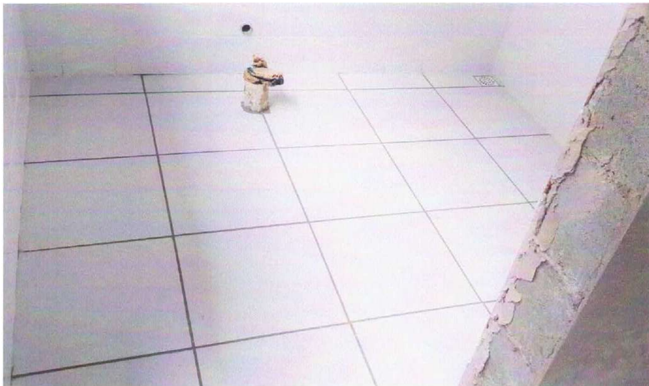
Foto 12: Instalação de piso cerâmico.
