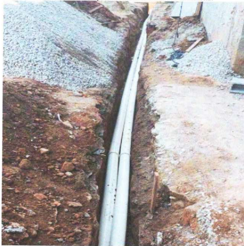
Foto 11: Instalação de infraestruturas hidráulicas.
